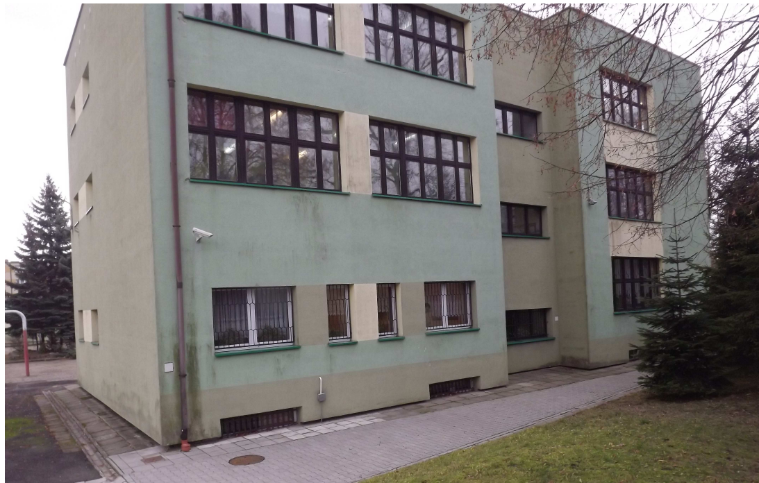
Fot. 5 - docelowa lokalizacja dobudowy wiatrolapu (wnęka)
