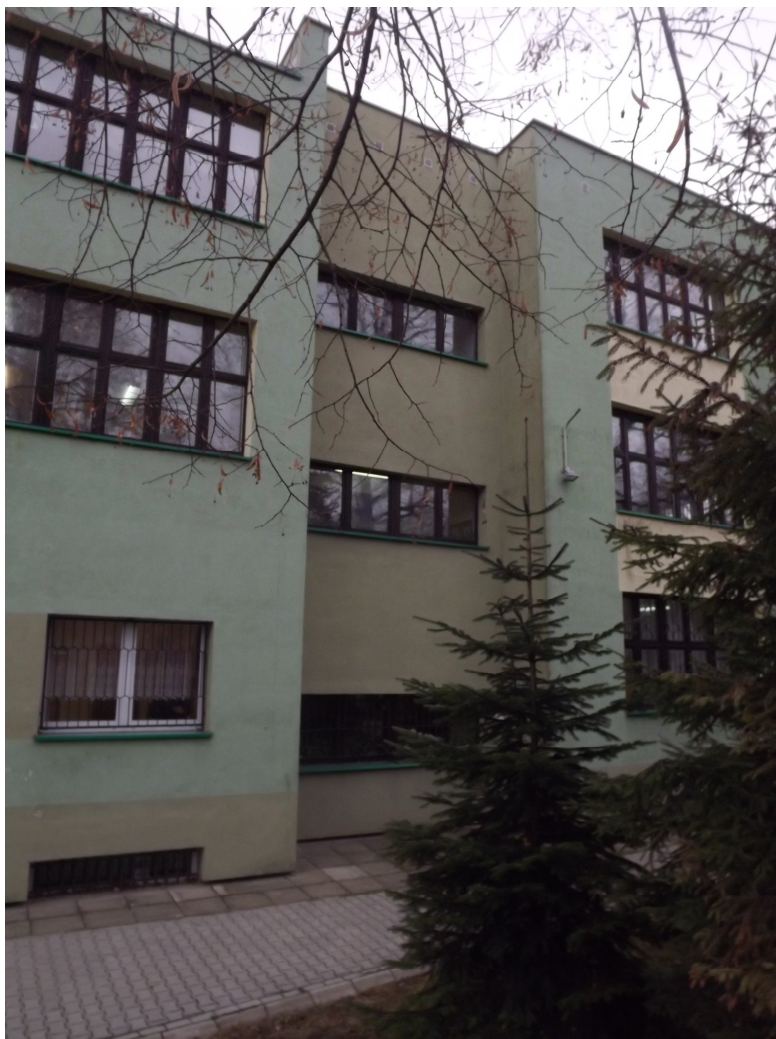
Fot. 6 - docelowa lokalizacja dobudowy wiatrołapu (wnęka)
