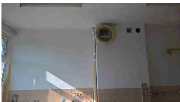
Fot. 3. Pomieszczenie kuchni, widok komina do adaptacji do wentylacji mechanicznej
